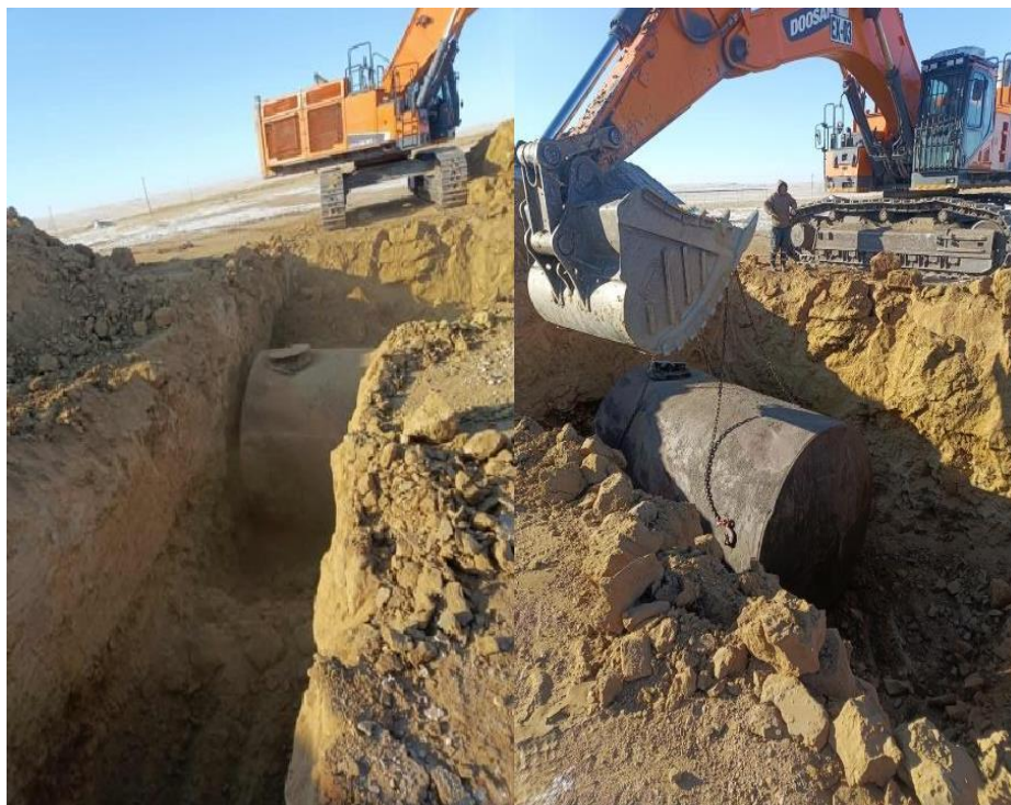
Зураг 1.Бохир хуримтлуулах 25 тн багтаамжтай танк суурилуулсан байдал.
