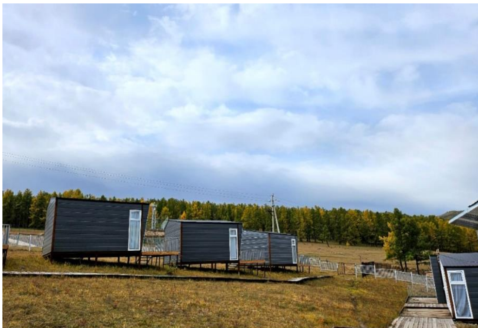
Барилга байгууламжийг гадсан суурьтай хийсэн байдал
