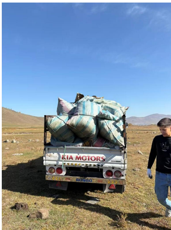
Зураг 5. Барилгын хогийг ачуулж буй зураг
