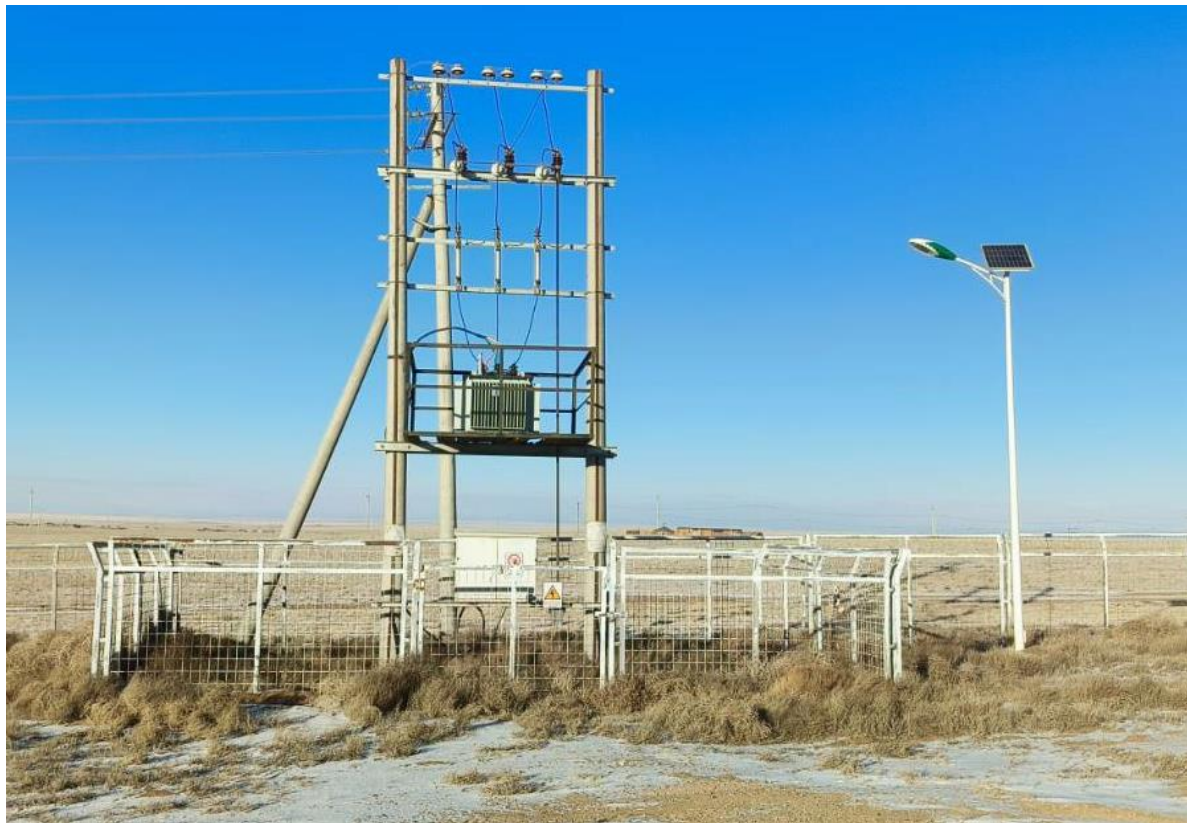
Зураг 10. Эрчим хүчний эх үүсвэрийн трансформатор
