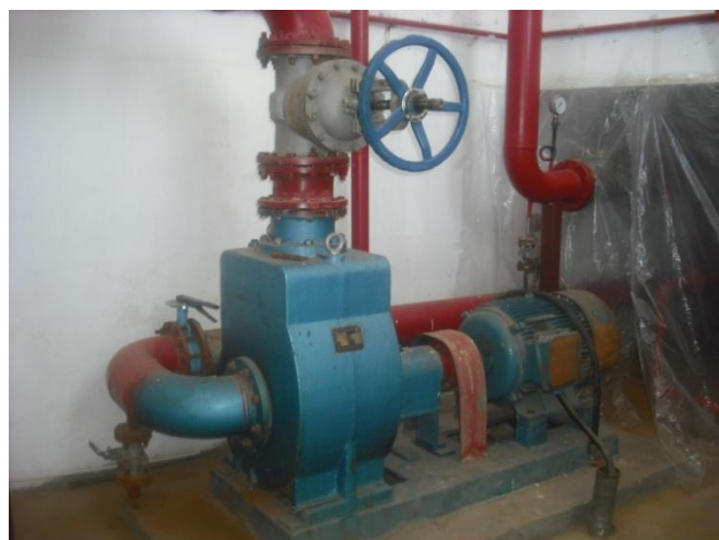
Зураг-8 Вагонцистерн буулгах байгууламжын хөргөлтийн болон гал унтраах хөөс шахах систем
