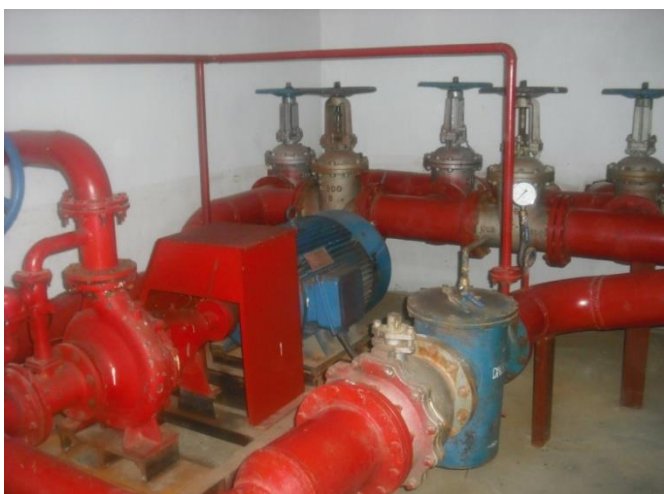
Зураг-8 Вагонцистерн буулгах байгууламжын хөргөлтийн болон гал унтраах хөөс шахах систем
