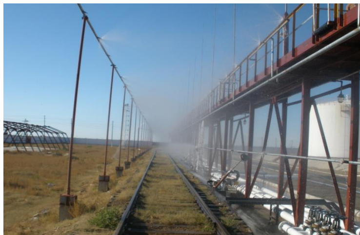
Зураг-8 Вагонцистерн буулгах байгууламжын хөргөлтийн болон гал унтраах хөөс шахах систем
