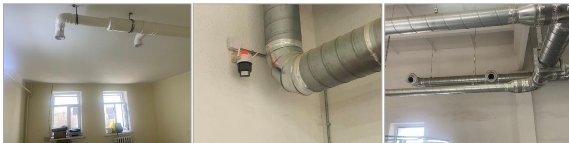
Зураг 14. Үйлдвэрийн дотоод орчны агааржуулалтын системийн сайжруулалт
