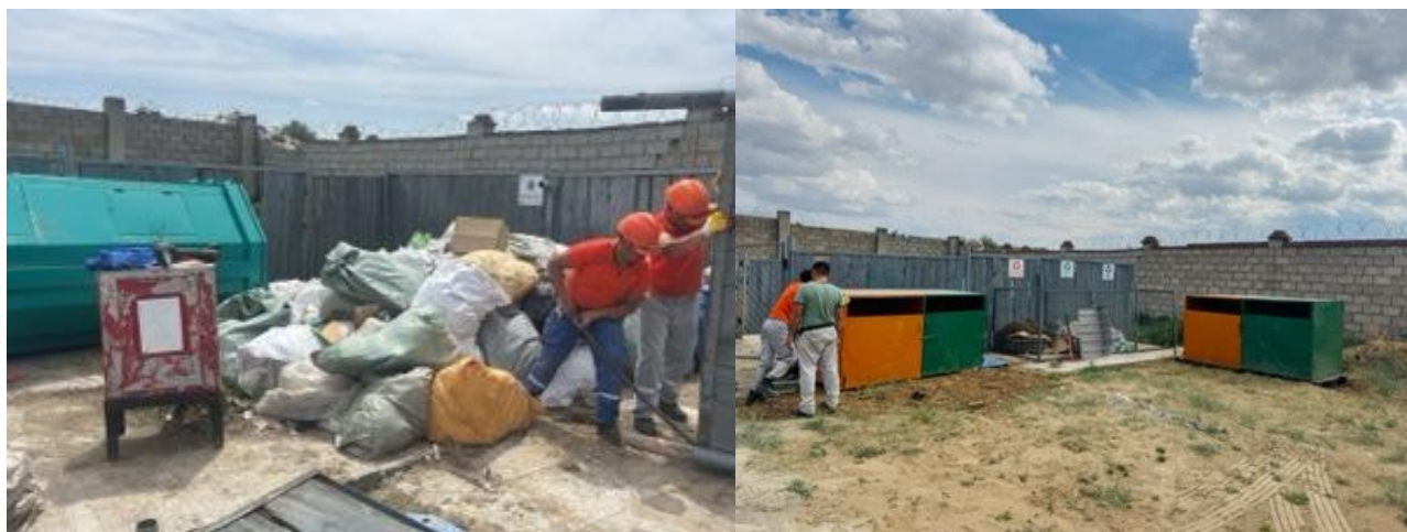
Зураг 48. Хог хаягдлын цэгт бетонон шал хийгдэхээс өмнөх үеийн зураг
