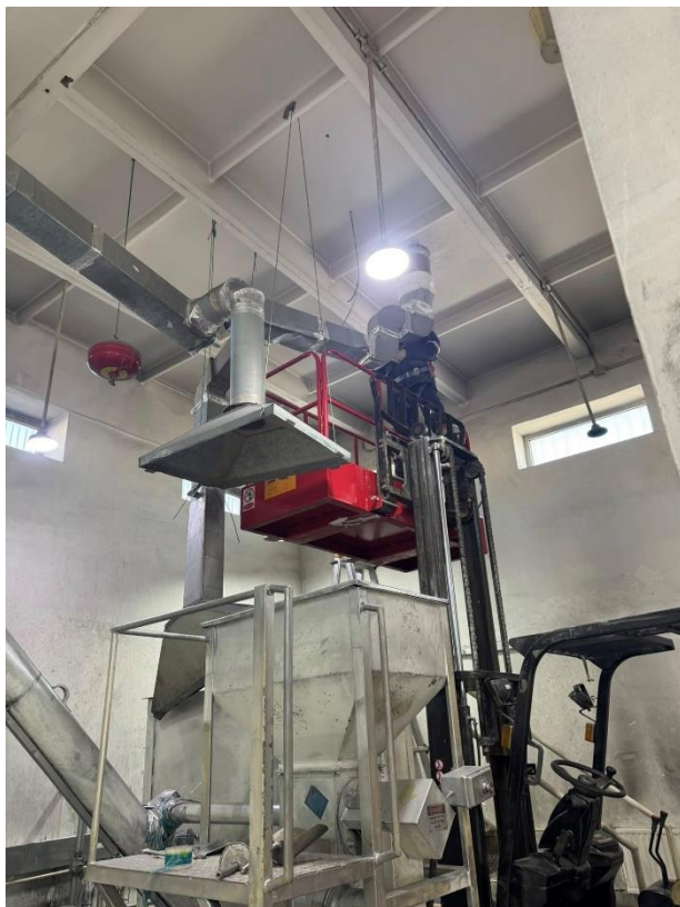
Зураг 10. Т14 үйлдвэрийн агааржуулалтын системийг засварлах явц
