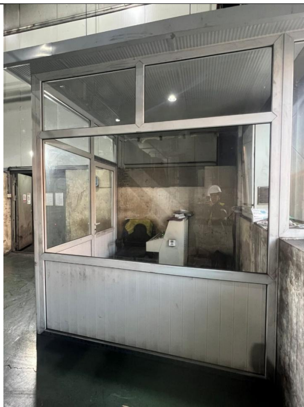
Зураг №2. Уурын зуухны операторын хяналтын өрөөг тусад нь гаргаж агааржуулалтыг шийдсэн байдал
