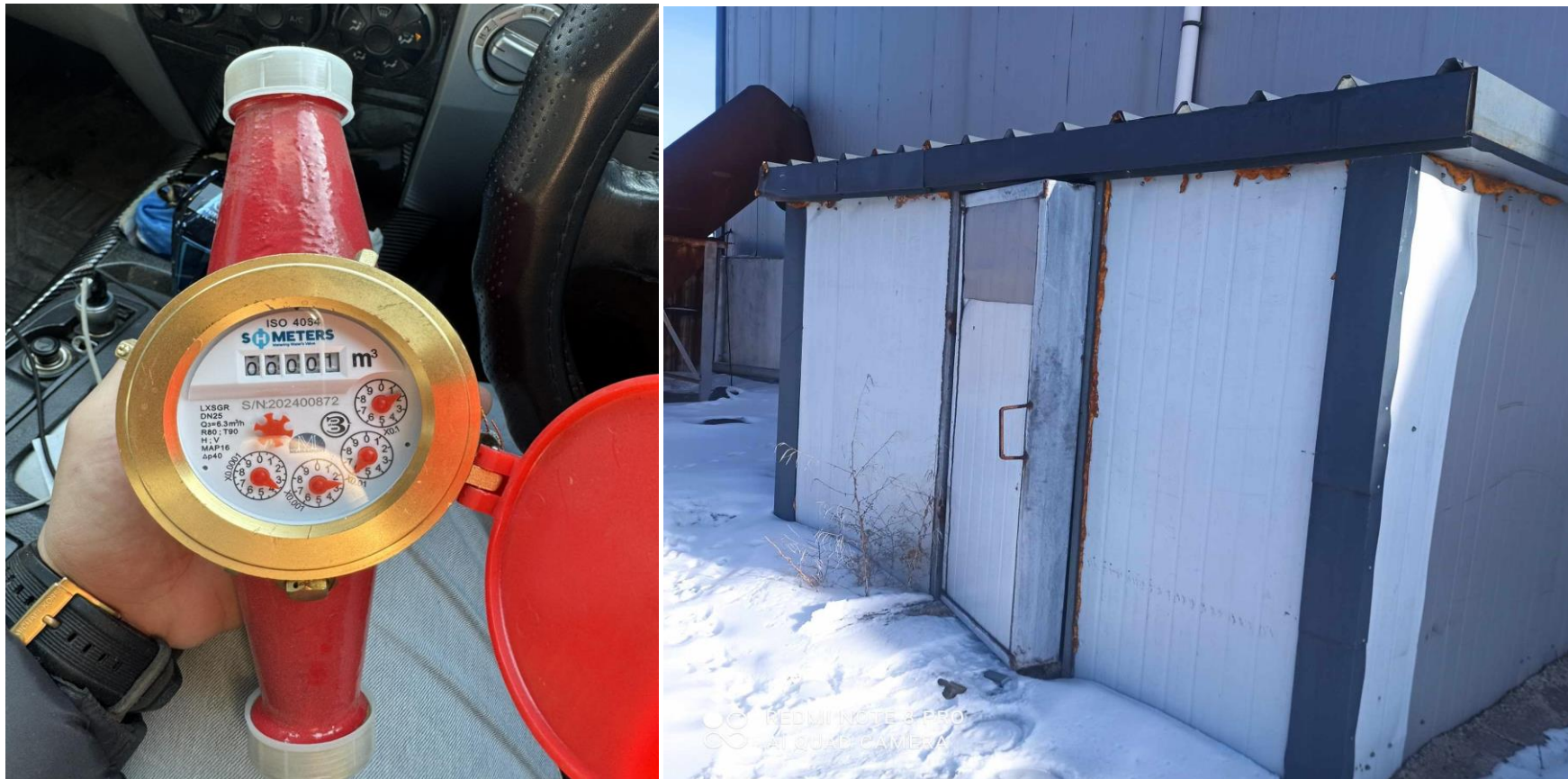
Зураг 10.Худгийг тоолууржуулж, тоолуур хамгаалах барилга барьсан байдал
