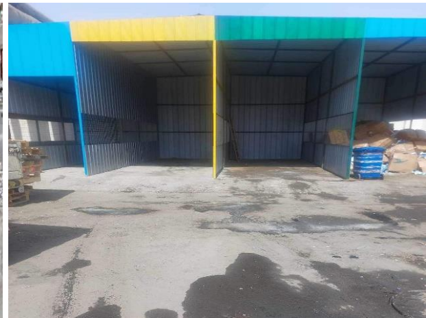
Зураг 25. Шинэ хогийн цэгийн барьж тохижуулсан байдал
