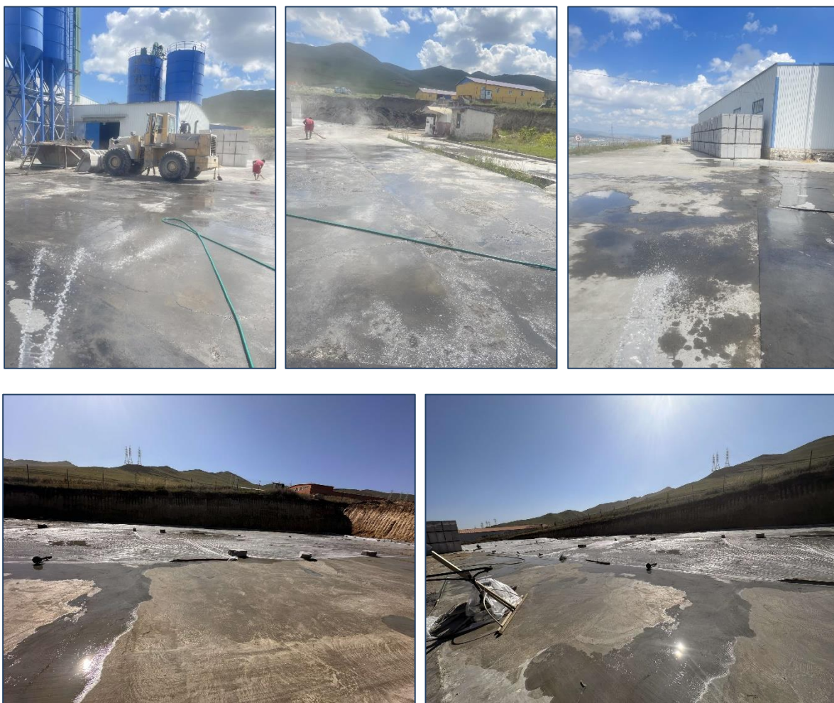
Зураг 6. Тоосжилттой үед үйлдвэрийн орчныг усалж чийгшүүлсэн байдал
