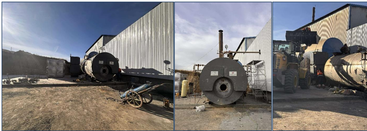
Зураг 2. Дизель уурын зуухыг үйлдвэрийн талбайд угсарч суурилуулах ажлын явц (2025 оны 6 сар)
