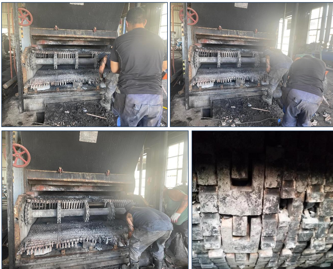
Зураг 4. Уурын зуухны үнсийг цэвэрлэх, ээлжит засвар үйлчилгээ хийж буй байдал
