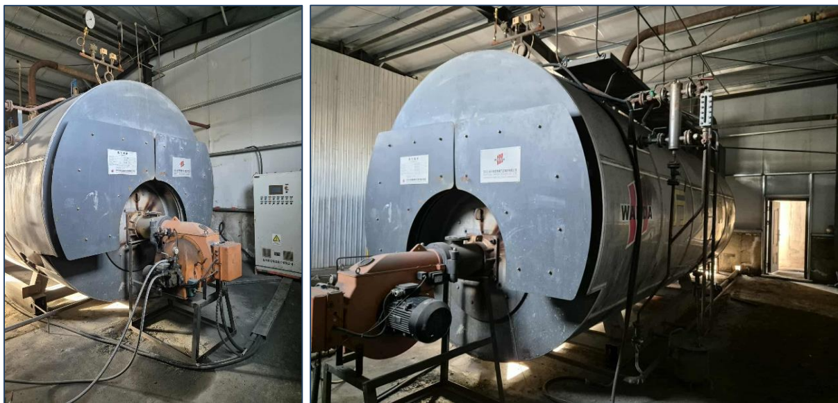
Зураг 3. Дизель уурын зуухыг бүрэн ашиглалтанд оруулсан байдал
