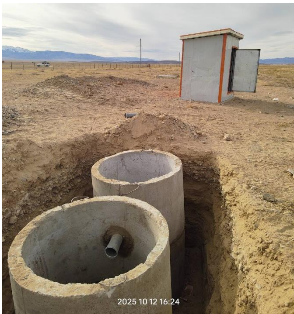
Бохирын цооног хийж буй байдал
