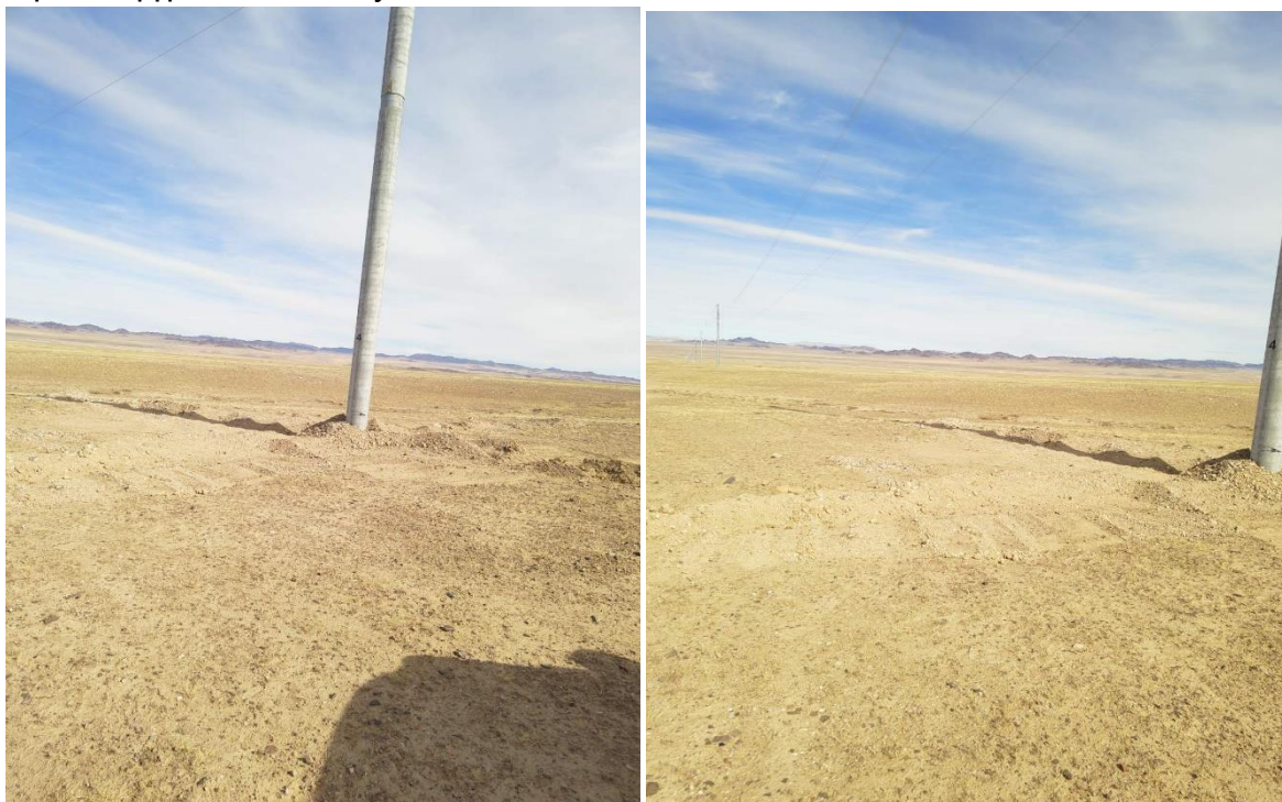
Цахилгааны ажил хийгдсэний дараа буцаан булж тэгшилсэн байдал
