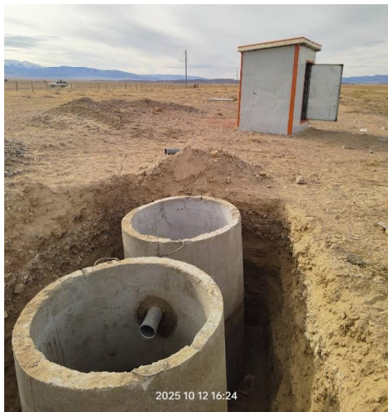
Ахуйн шингэн хаягдал хуримтлуулах бохирын цооног хийж буй байдал
