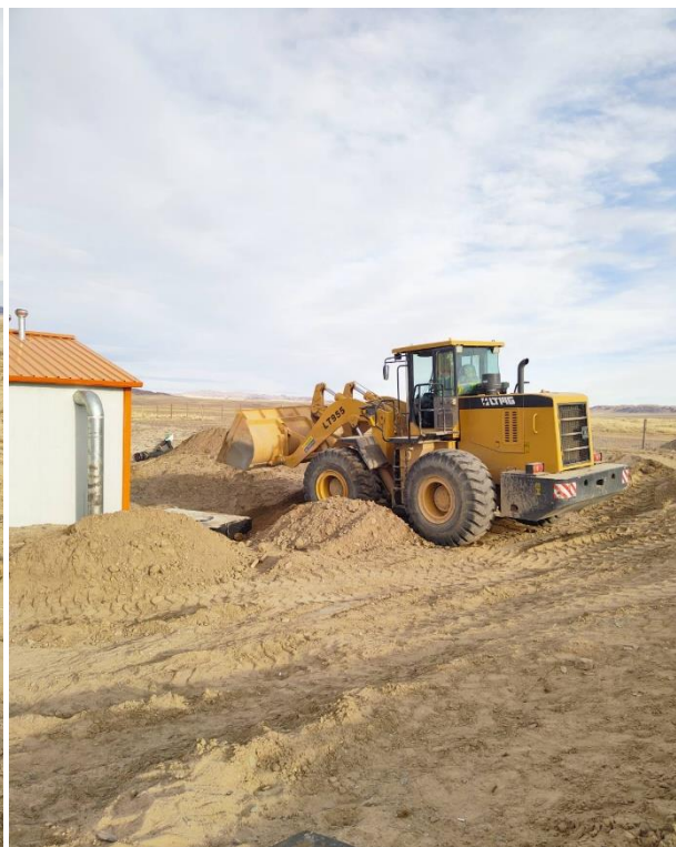
Газар шорооны ажил дуусны дараах тэгшилгээний ажил хийгдсэж буй байдал
