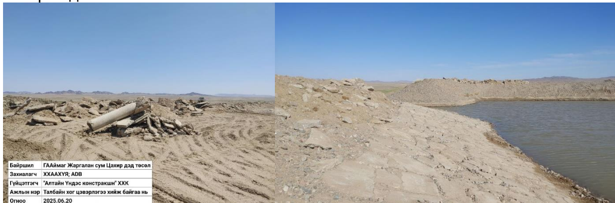
Дахин ашиглах боломжтой бетонгийг цуглуулсан байдал
