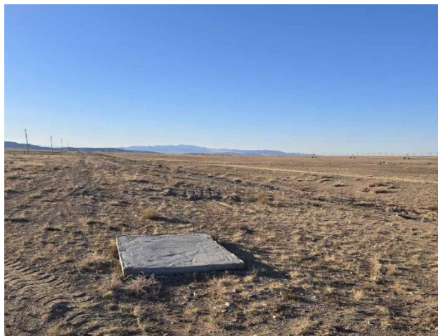
Түр хог хадгалах цэг байгуулах бетон суурь бэлдсэн байдал
