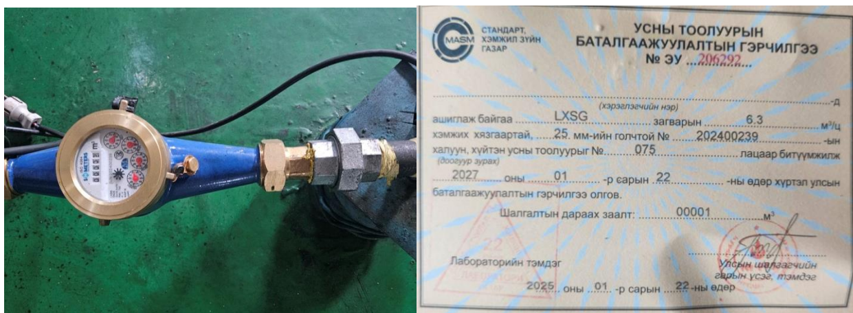
Зураг 2. Хаягдал боловсруулах үйлдвэрийн худагт тавьсан усны тоолуур
