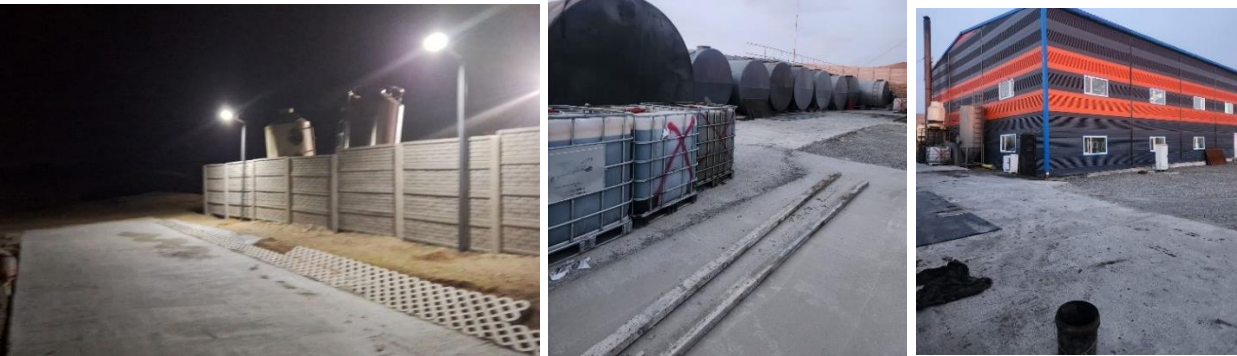
Зураг 4. Төслийн талбай, орчны газрыг хатуу хучилттай болгосон байдал
