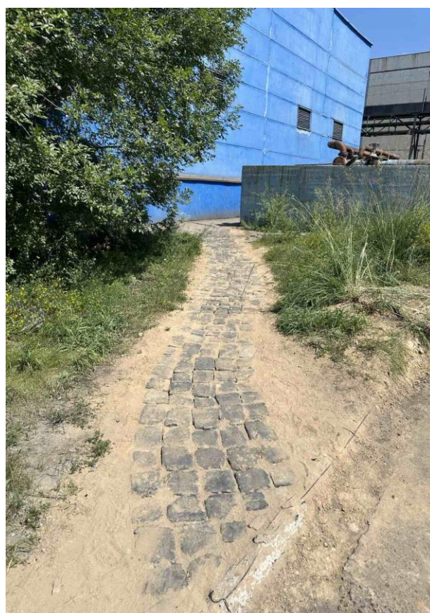
Зураг 4 Хаягдал тоосго ашиглан явган хүний зам хийсэн байдал
