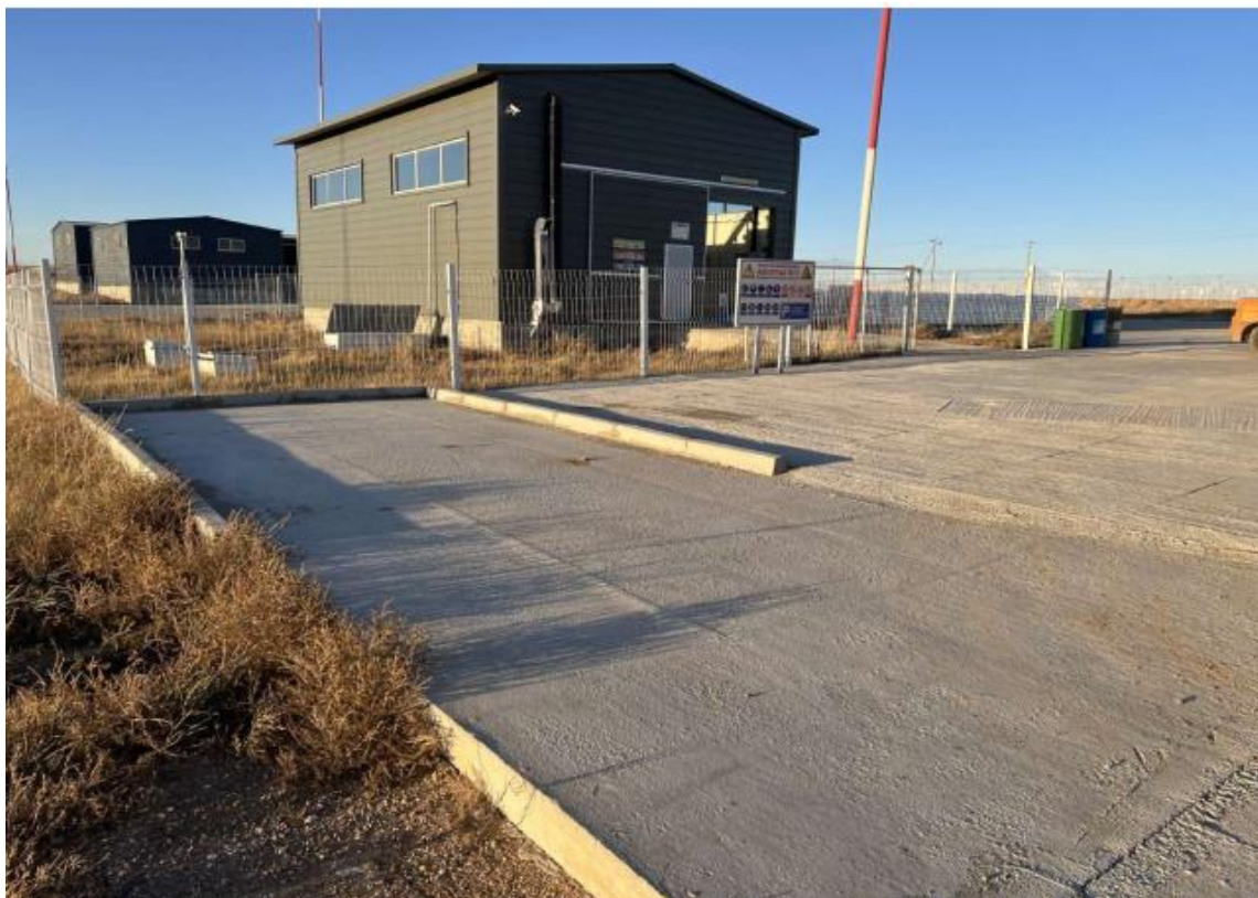
Зураг 19. Үйлдвэрийн гадна автомашины зогсоолыг 3000м 2 талбайг бетондсон байдал
