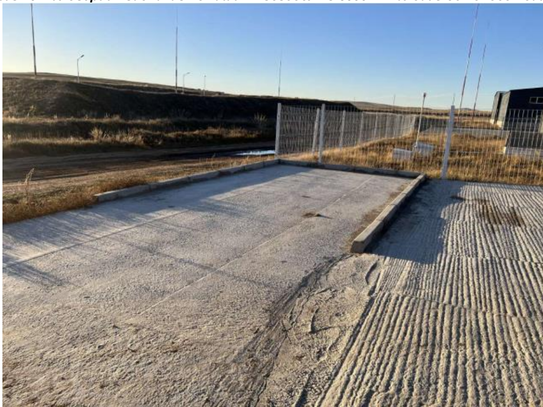
Зураг 20. Үйлдвэрийн гадна автомашины зогсоолыг 3000 м 2 талбайг бетондсон байдал
