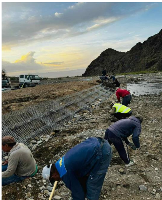
Зураг 12: Үерээс хамгаалах даланг габион дотор чулуун өргөөр бэхэлж байгаа байдал /далангийн урт сууриараа 9м, дээд талаараа 6м, өндөр 1.5м/
