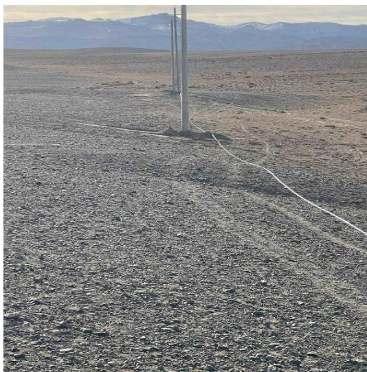
Зураг 25: Шон суулгаж утас татаж дууссаны дараа ухсан нүх шороог хэвийн байдалд оруулсан нь
