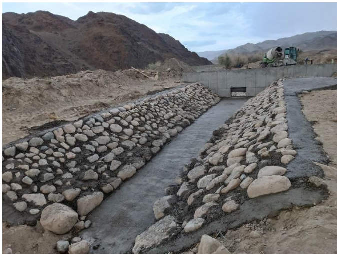
Зураг 10: Ус татамжийн барилгыг, ёроолыг бетонон сууриар доторлож чулуун өрлөгөөр өрж шүүрэлтээс сэргийлж хийсэн байдал.
