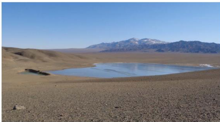
Зураг 11: Эвдэрч муудсан ус хуримтлуулах боломжгүй байсан хиймэл нуурыг сэргээн засварлаж, 4метрийн өндөр далан байгуулж ус хуримтлуулав.
