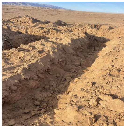
Зураг 24: Кабель утас, газардуулгын шин татахад нүх ухсан байдал
