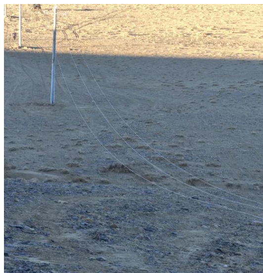
Зураг 26: Шон суулгаж утас татаж дууссаны дараа ухсан нүх шороог хэвийн байдалд оруулсан нь
