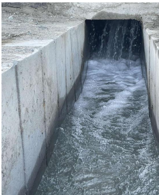
Зураг 7,8: Толгойн барилгаас ус гаргах болон оруулж шалгаж байгаа байдал
