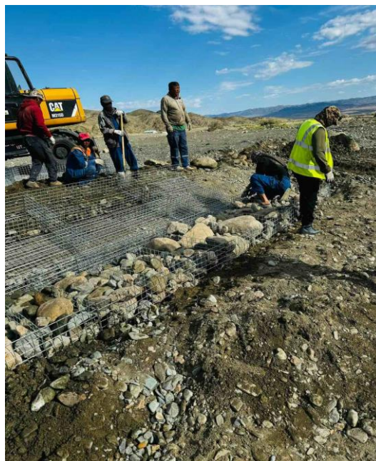
Зураг 12: Үерээс хамгаалах даланг габион дотор чулуун өргөөр бэхэлж байгаа байдал /далангийн урт сууриараа 9м, дээд талаараа 6м, өндөр 1.5м/
