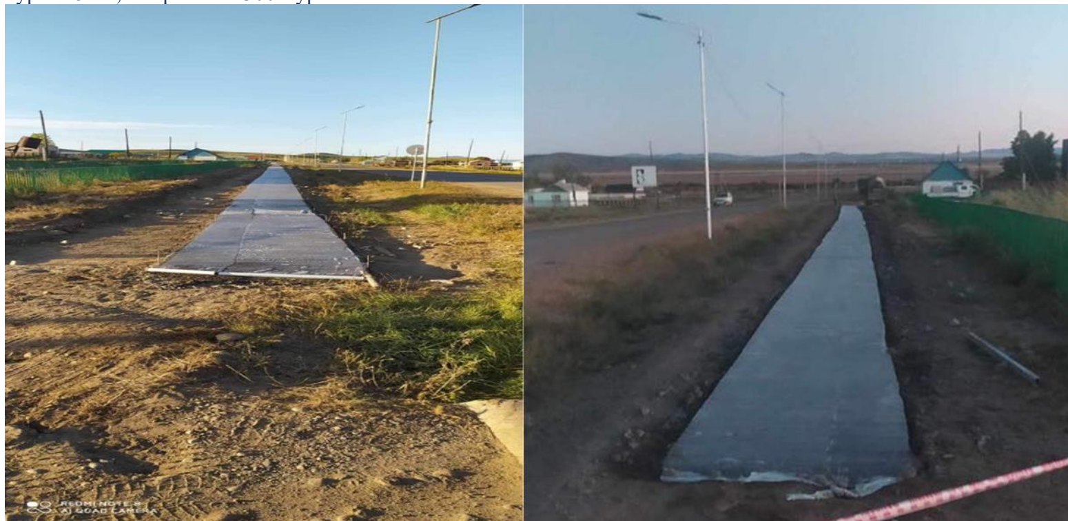
Зураг 28. “1,2м өргөнтэй 300м урттай бетон зам”
