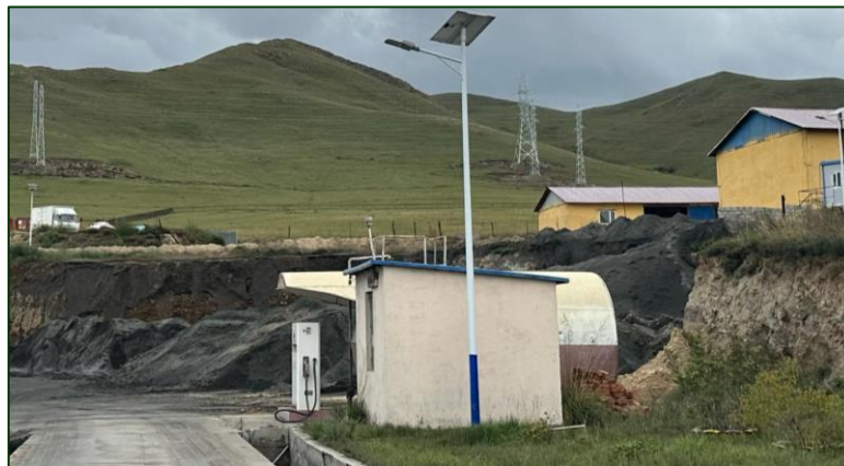
Зураг 11. Үйлдвэрийн хашаан дахь дизель түлшний нөөцийн агуулах, түгээх хэсэг
