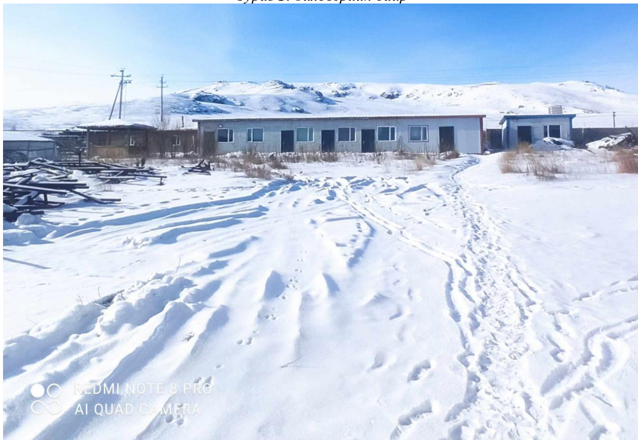
Зураг 3. Үйлдвэрийн байр
