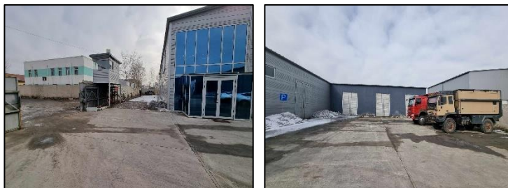
Зураг 3. Төслийн талбайн хатуу хучилттай авто машины зогсоол
