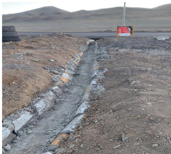
Хавсралт №09 Шатахуунаар бохирдсон гадаргуугийн хур тунадас зайлуулах сувгийг төлөвлөх. Галын аюулгүй байдлын норм БНБД - 21.07.14 Шатахуунаар бохирдсон гадаргуугийн хур тунадас зайлуулах сувгийг хийсэн
