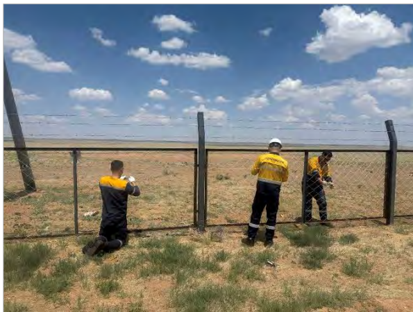
Хашааны засвар хийж буй байдал
