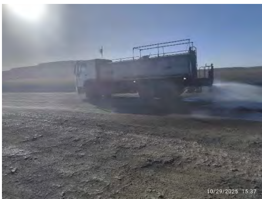
Зураг № 4. Хаягдлын овоолгын тээвэрлэлт хийх үед усалгаа хийж буй байдал
