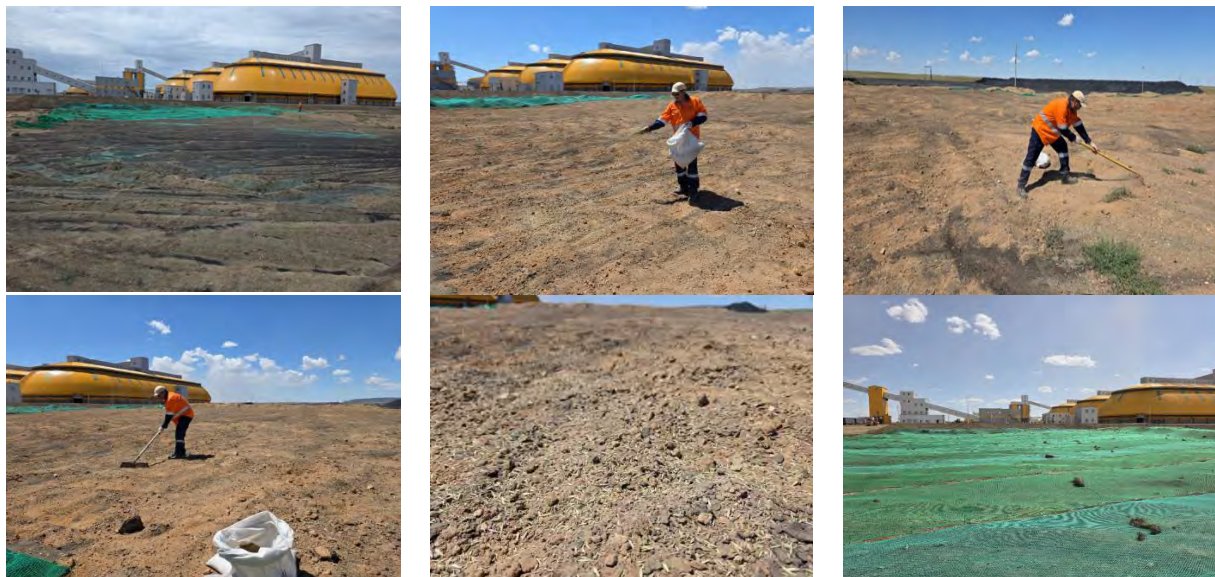
Зураг № 52. Шимт хөрсний овоолгын ургамалжуулалт хийж буй байдал
