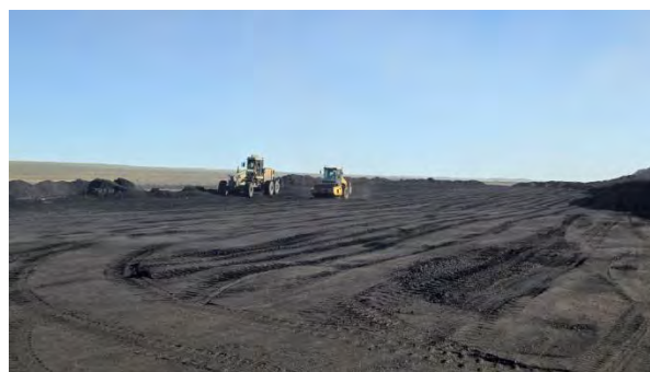
Зураг № 7. Хаягдлын овоолго үүсгэж, нягтаршуулж буй байдал
