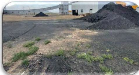
Том ширхэгтэй үнс буулгах талбай M200 бетон 46.8м 3 , Ф12 арматур 2040кг
