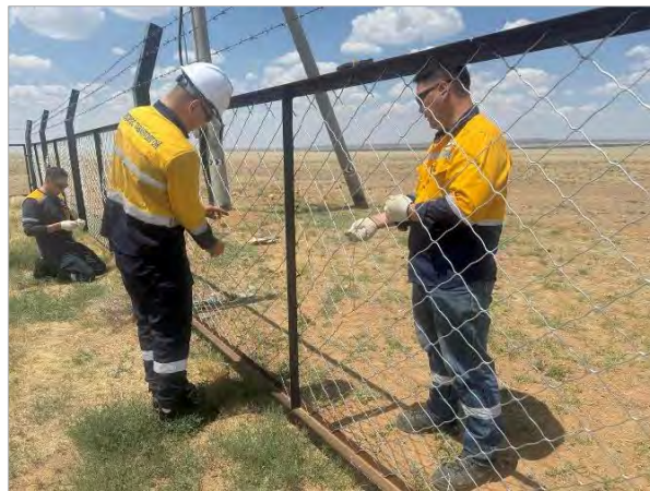
Хашааны засвар хийж буй байдал
