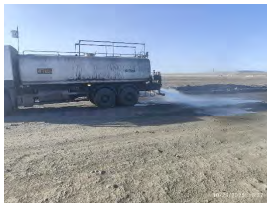
Зураг № 4. Хаягдлын овоолгын тээвэрлэлт хийх үед усалгаа хийж буй байдал
