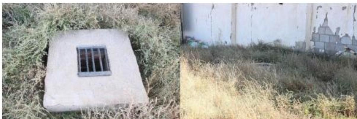
Зураг 9. Бохирын цооногийг бетондсон байдал
