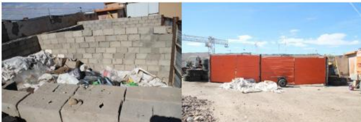
Зураг 6. Хог хаягдлын цэгийг хатуу хучилттай болгосон байдал
