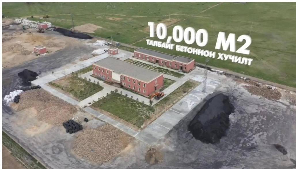
Талбай бетондсон зураг
