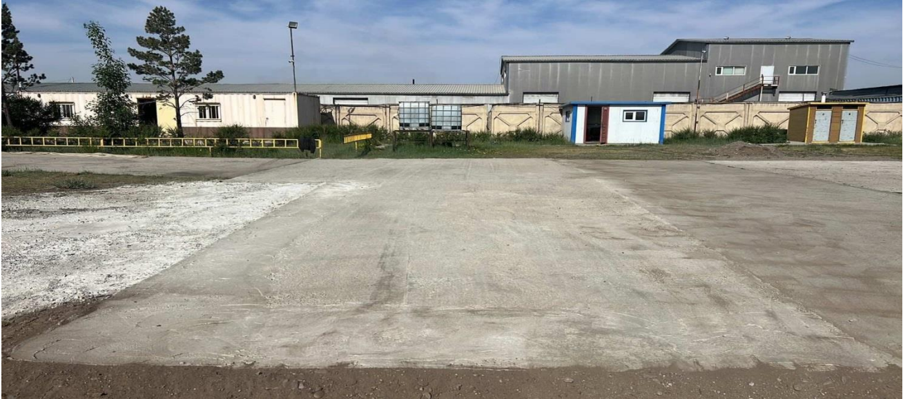
Зураг 14. Хөрс бетонжуулалт
