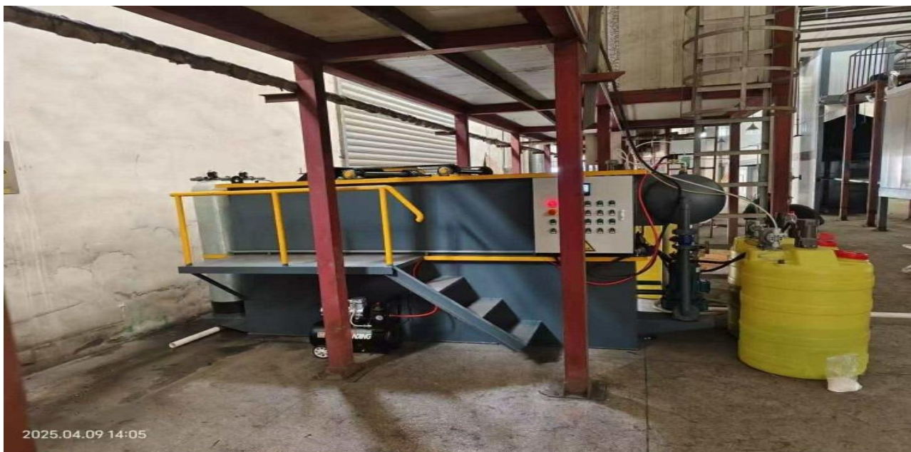
Зураг 17. Саарал усны цэвэршүүлэгч тоног төхөөрөмж
