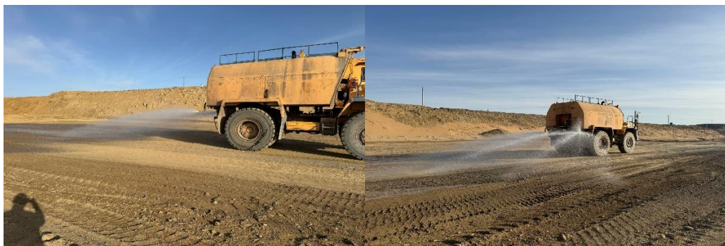
Зураг 3. Зам усалгаа хийж буй байдал
