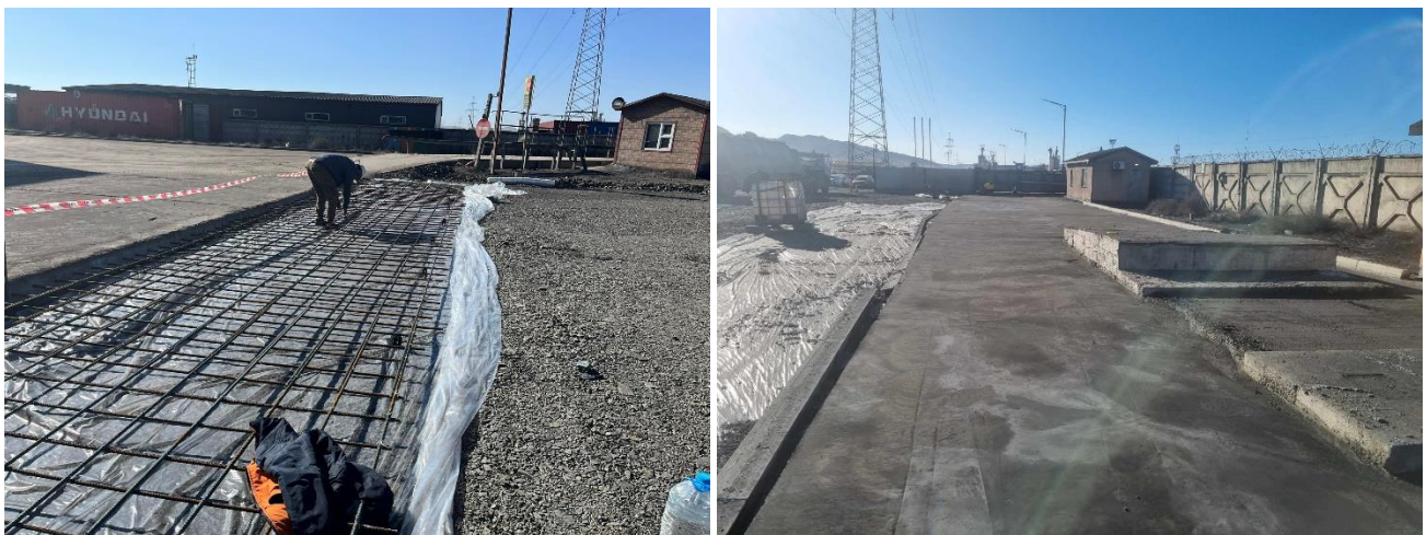
Зураг 8. Үйлдвэрийн зам талбайг бетондож хучилттай болгож буй байдал
