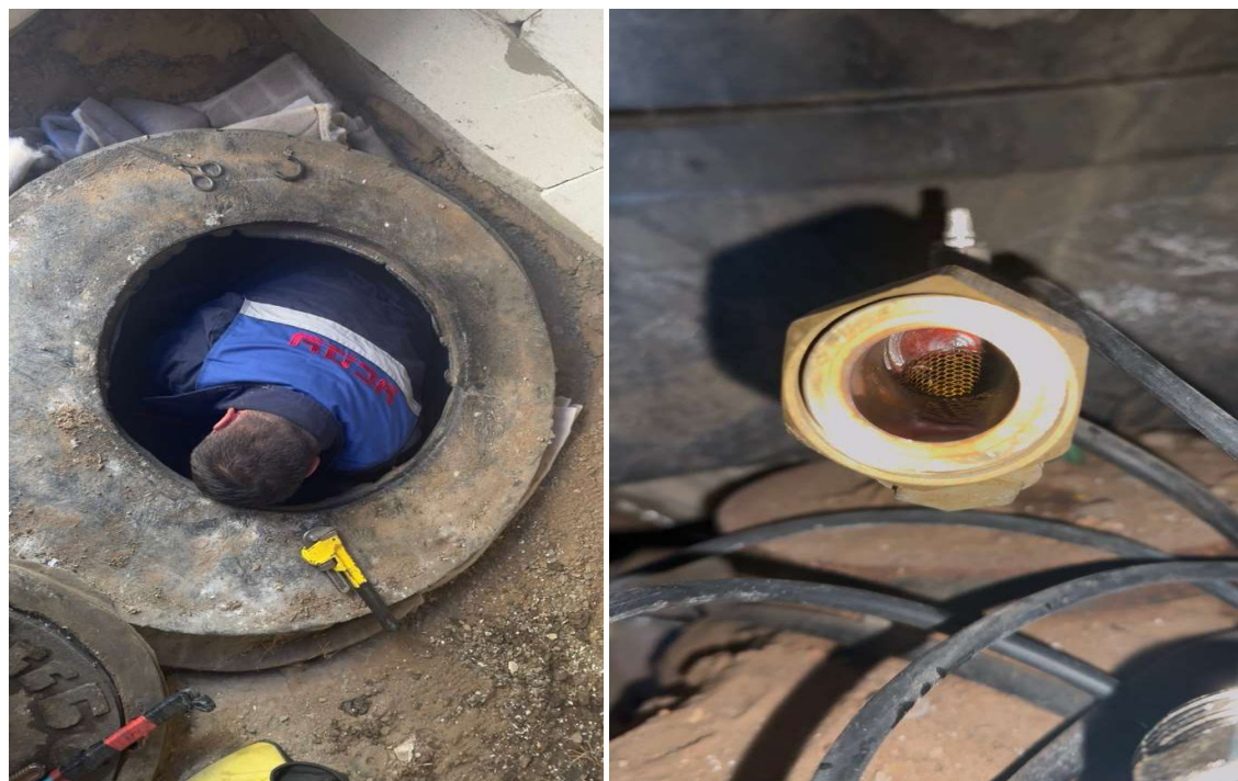
Зураг 20. Гүний усны цоргоны жийргэвч резинийг сольж буй байдал
