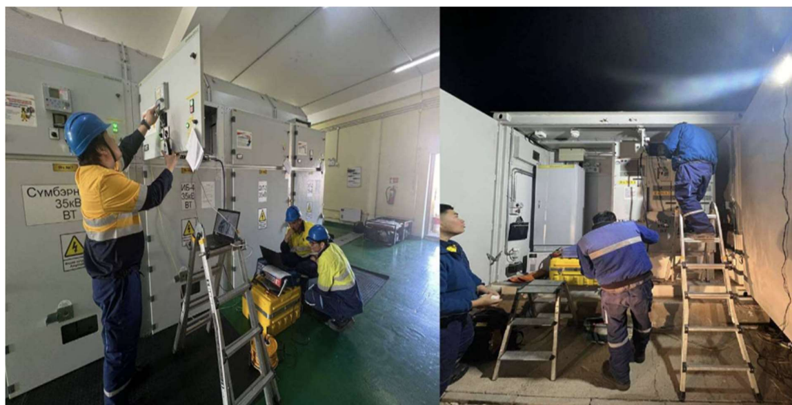
Зураг 23. Реле хамгаалалтын хэмжилт, туршилт хийж буй байдал болон хэмжилт туршилтын гүйцэтгэлийн акт
