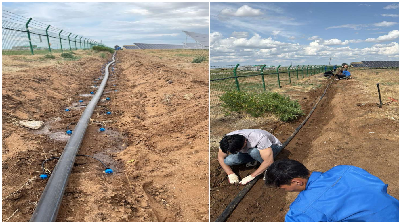
Зураг 21. Модны усалгааны систем угсарч буй байдал
