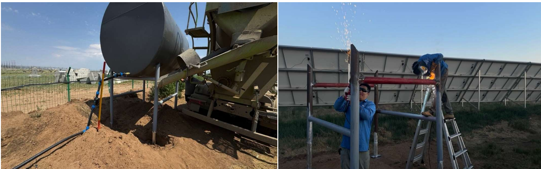
Зураг 22. Усны нөөцлүүрийн сав угсарч буй байдал
