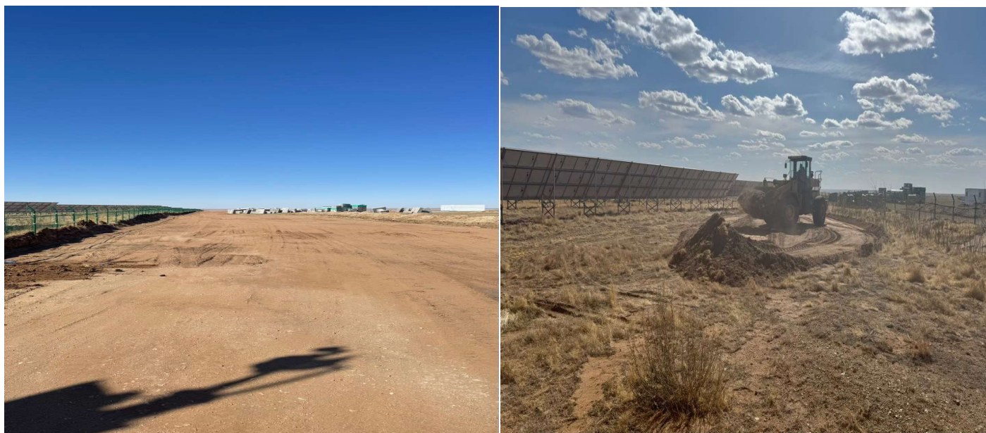
Зураг 19. Төслийн талбайд шуурсан элсийг зөөж хаяж буй байдал
