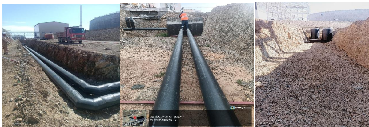
Зураг 2-12. Ус дамжуулах хоолой угсрах ажил
