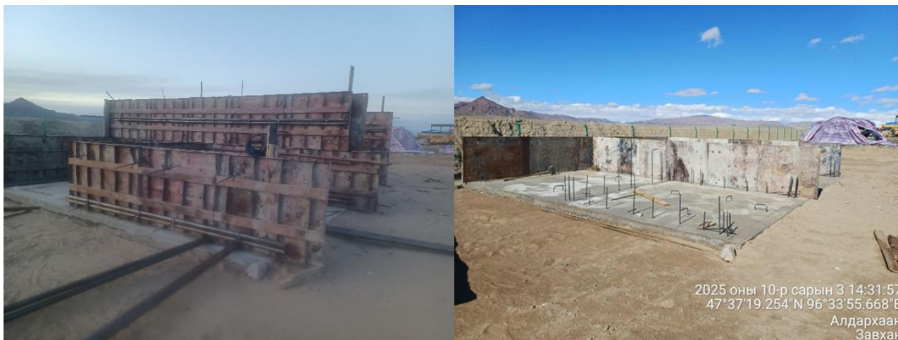
Зураг 20. Хатуу хог хаягдын байгууламжийг барих явц /одоогоор баригдаж дуусаагүй байгаа/
