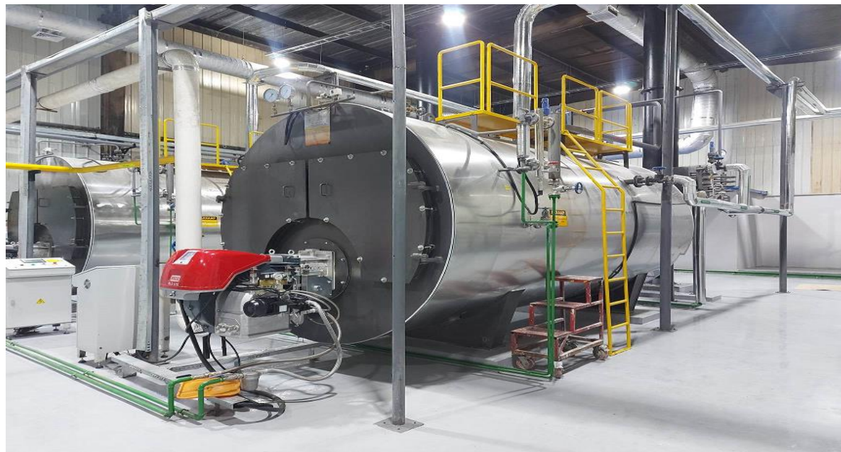
Зураг 1-7-1 Итали улсын RLS-610 маркын ноцоогуур ба тэжээлийн 2 системтэй. LPG (Liquefied petroleum gas/Шингэрүүлсэн нефтийн хий) болон Diesel (Түлш)
