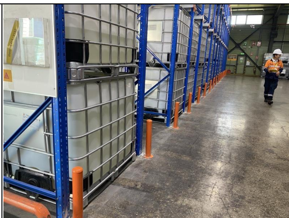
Зураг 3-42. Агуулахын тавиурын хатуу хамгаалалтыг шинэчилсэн байдал
