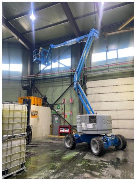
Зураг 3-30. Галын дохиолол, утаа мэдрэг, таазны шугаман мэдрэгчийн ажиллагааг шалгаж буй байдал.
