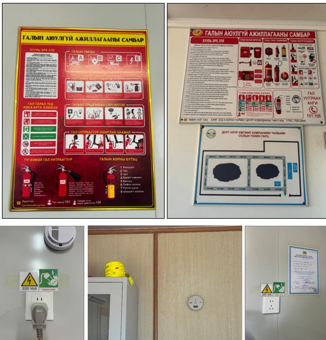
Зураг 60. Галын аюулгүй ажиллагааны самбар, галын дохиоллын систем, тэмдэг тэмдэглэгээ
