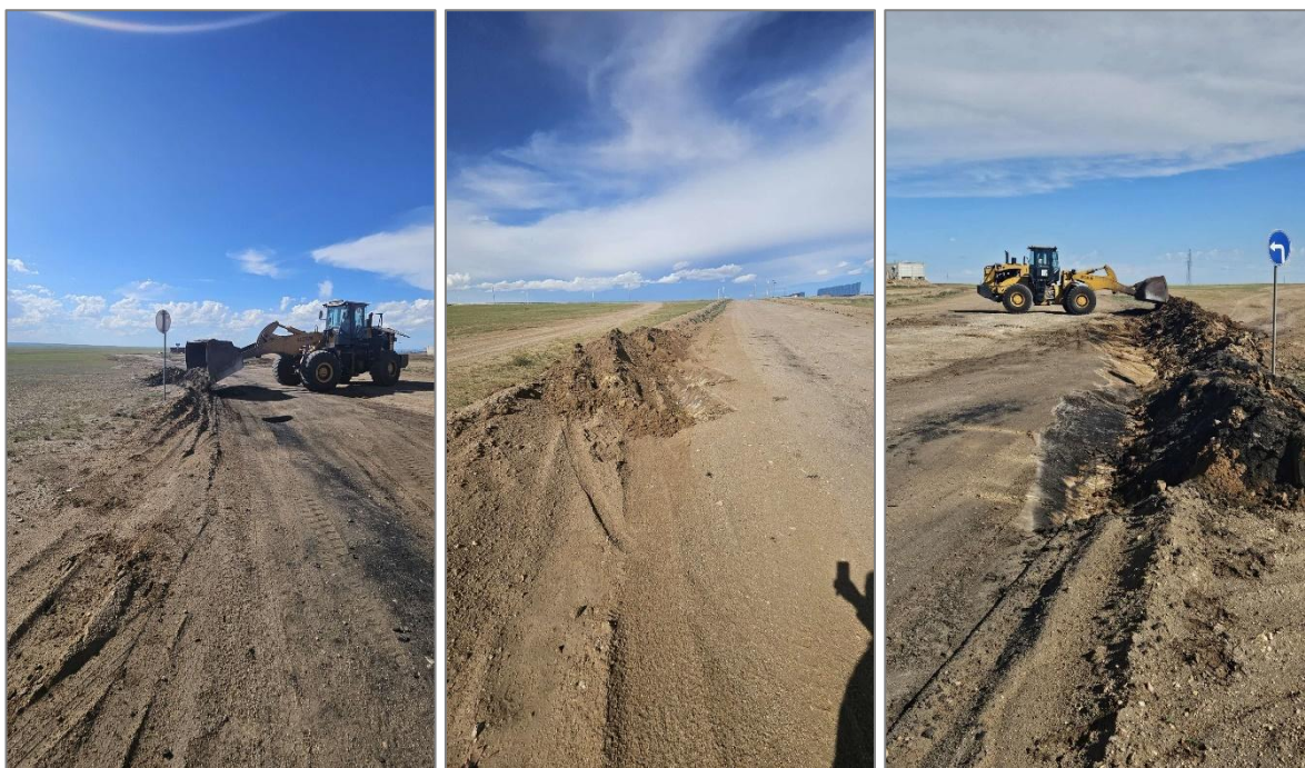
Зураг 65. Зам засварын ажил гүйцэтгэж буй явц
