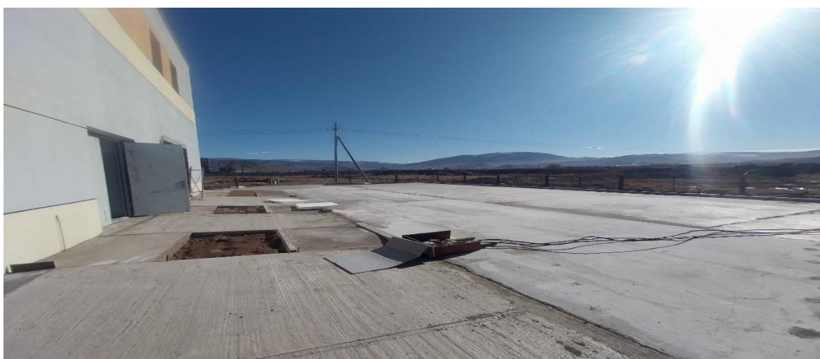
Зураг 11. ЦБ газрын доторх шугам хоолой, авто болон явган хүний замын ажил, гэрэлтүүлэг гэх мэт орчны гадна тохижилтын ажил дууссан байдал
