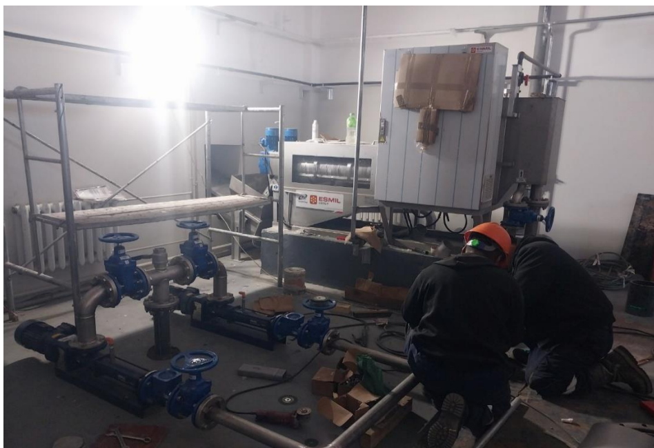
Зураг 3.Тоног төхөөрөмжийн суурилуулалт хийж буй
