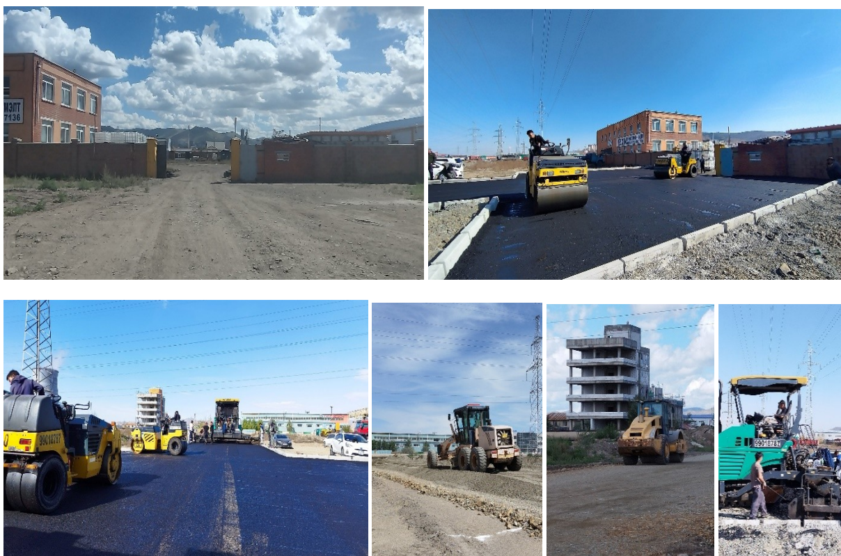
Хавсралт зураг-21. Төв замаас үйлдвэр хүртэлх зоричх хэсгийн замыг асфалтан зам болгож байгаа байдал.
