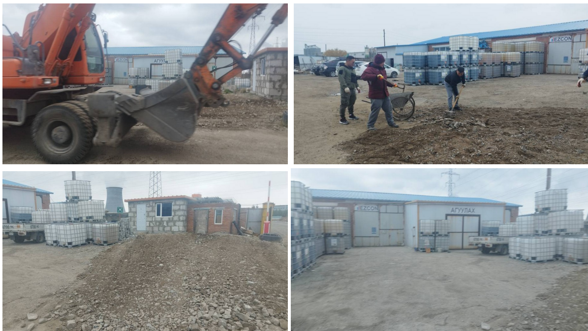
Хавсралт зураг-21. Төв замаас үйлдвэр хүртэлх зоричх хэсгийн замыг асфалтан зам болгож байгаа байдал.
