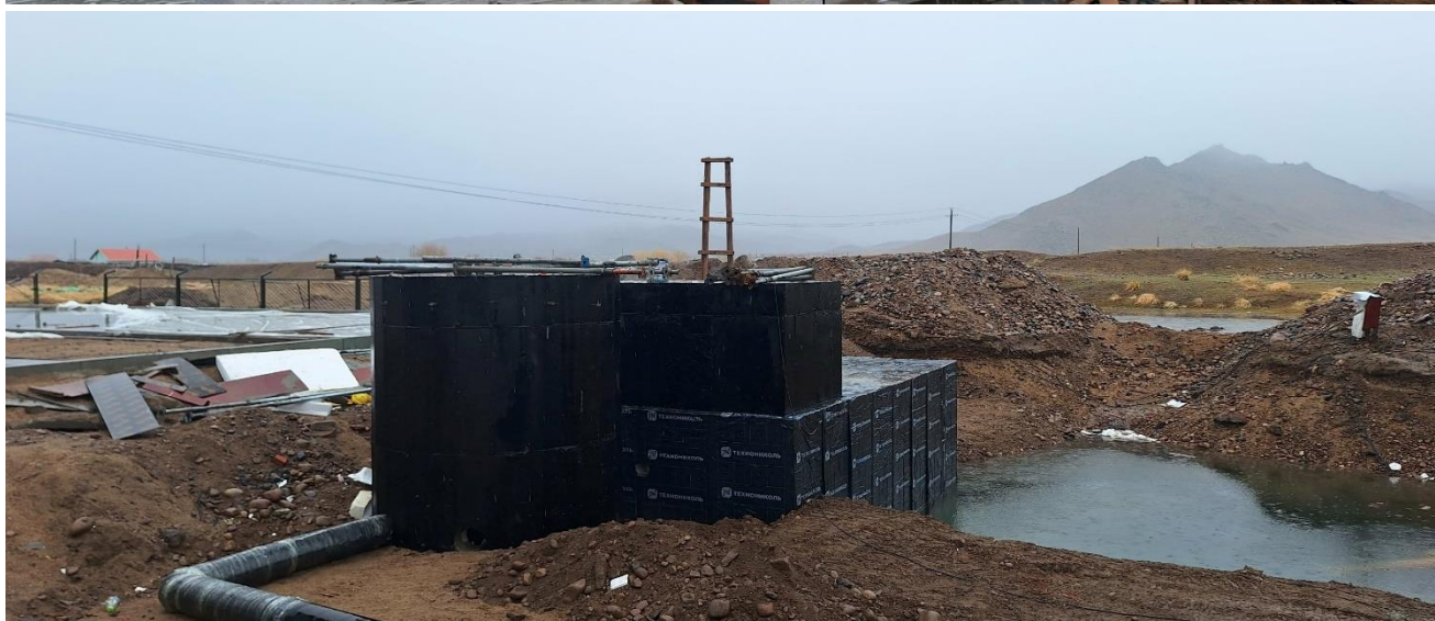
Биореактор, насос станц, шугам хоолойн угсралт холболтын ажил
