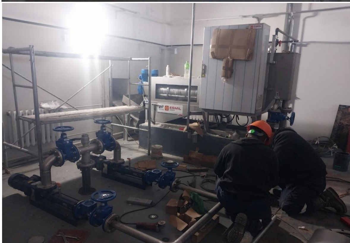
Зураг 4. Тоног төхөөрөмжийн суурилуулалт хийж буй
