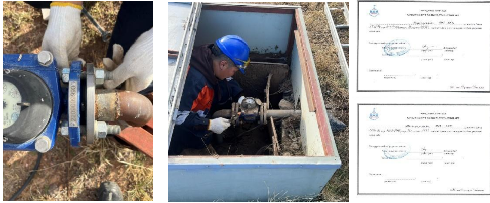
Зураг 13. “Чандмань Илч”ХХК тоолуур суурилуулж буй байдал 2025.04 сар
