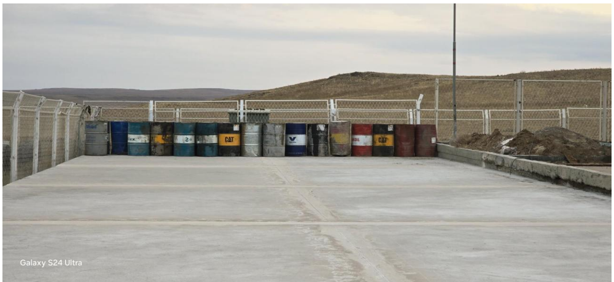
Зураг 25. Поошиг хадгалах талбайг бетон суурьтай болгосон байдал
