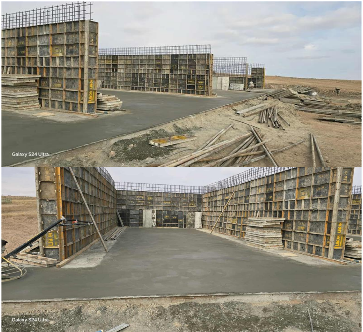
Зураг 52. Шинэ түр хогийн цэгийн барилгын ажлын явц
