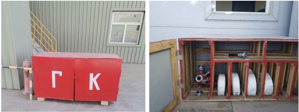
Зураг 46. Галын гидрантуудын ажиллагааг шалгаж бүрэн бүтэн байдлыг хангасан
