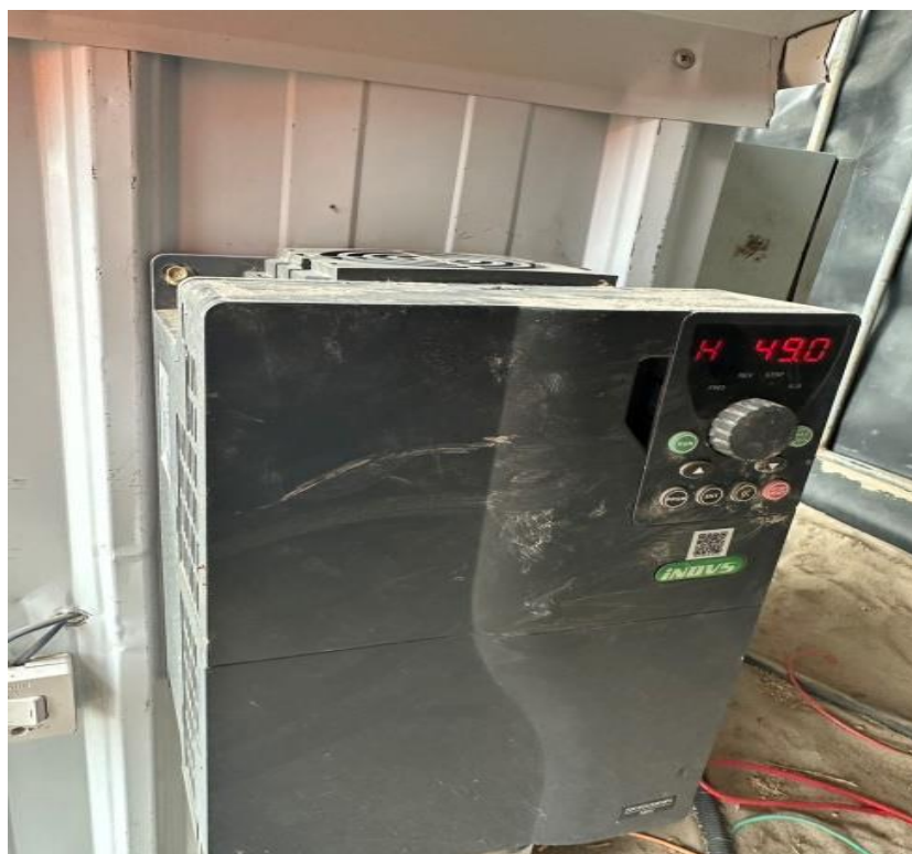
Зураг 7. Ногоон байгууламжийн усалгаа хийхэд ашиглах, усны зориулалтын инвертер тавьж хэмнэлт хийж байгаа
