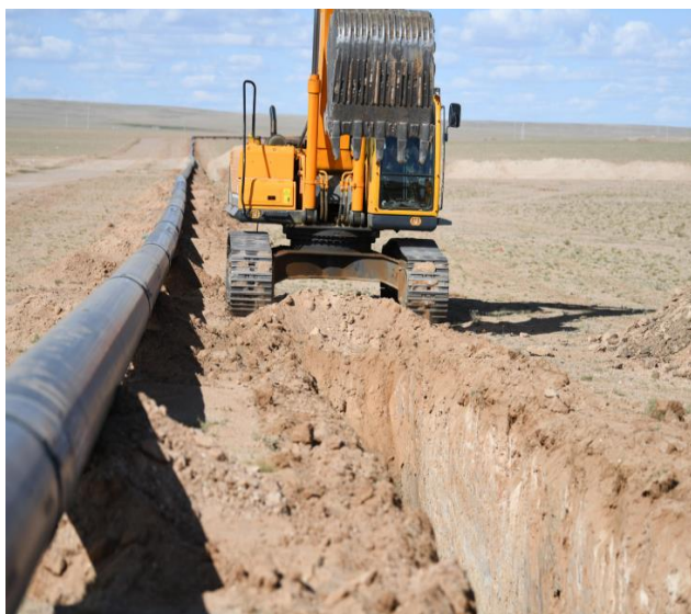
Зураг 4. Түүхий тос дамжуулах хоолой суурьлуулах, хөрс ухалтын ажил
