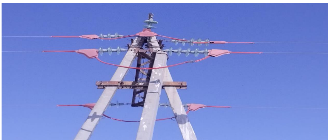
Зураг 8.СВ-11 маркийн төмөр бетонон анкерт шувуу хамгаалах полимер суурилуулсан байдал.
