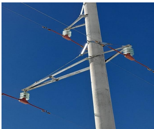
Зураг 9.3ТБ-18 , СВ-11 маркийн төмөр бетонон дундын тулгуурт шувуу хамгаалах полимер суурилуулсан байдал
