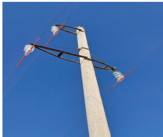
Зураг 7.У-35 2Т маркийн төмөр анкер болон СВ-15 маркийн төмөр бетонон анкерт шувуу хамгаалах полимер суурилуулсан байдал.
