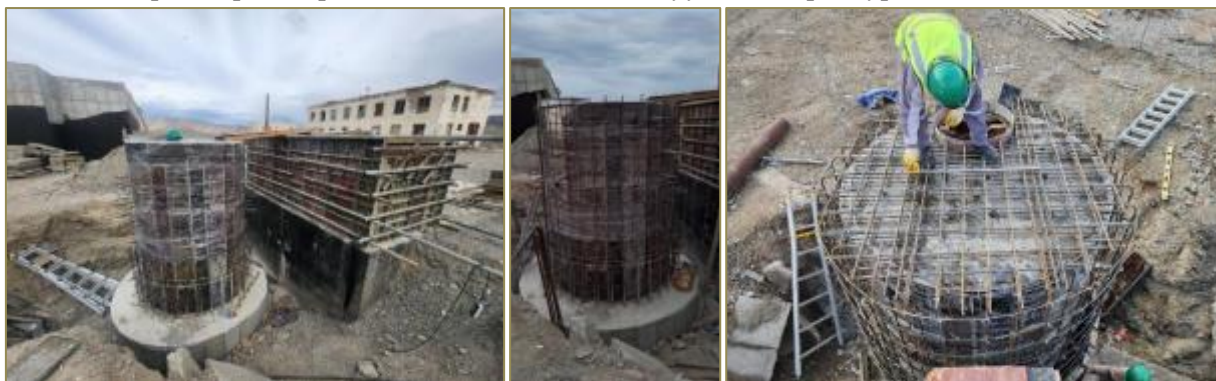
Насос станцын барилгын арматурын ажил хийсэн байдал
