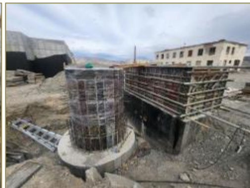
Насос станцын барилга угсралт
