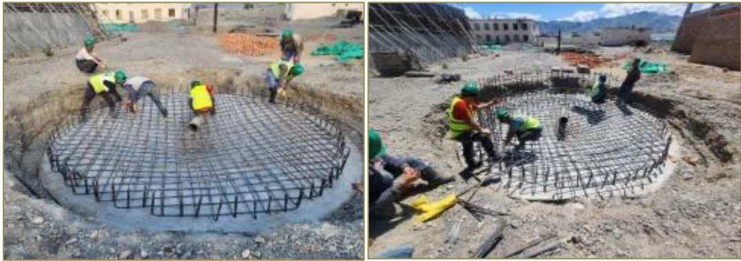
Лаг хадгалах камер-н барилгын суурийн арматурын ажил хийж буй байдал
