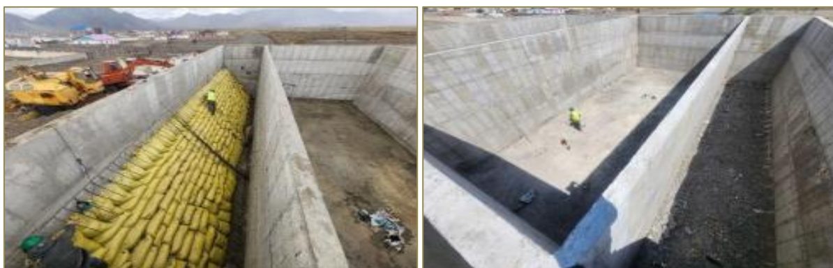
Биологи реакторын барилгын - X5 тэнхлэгийн налуу ханын арматурын ажил хийсэн байдал
