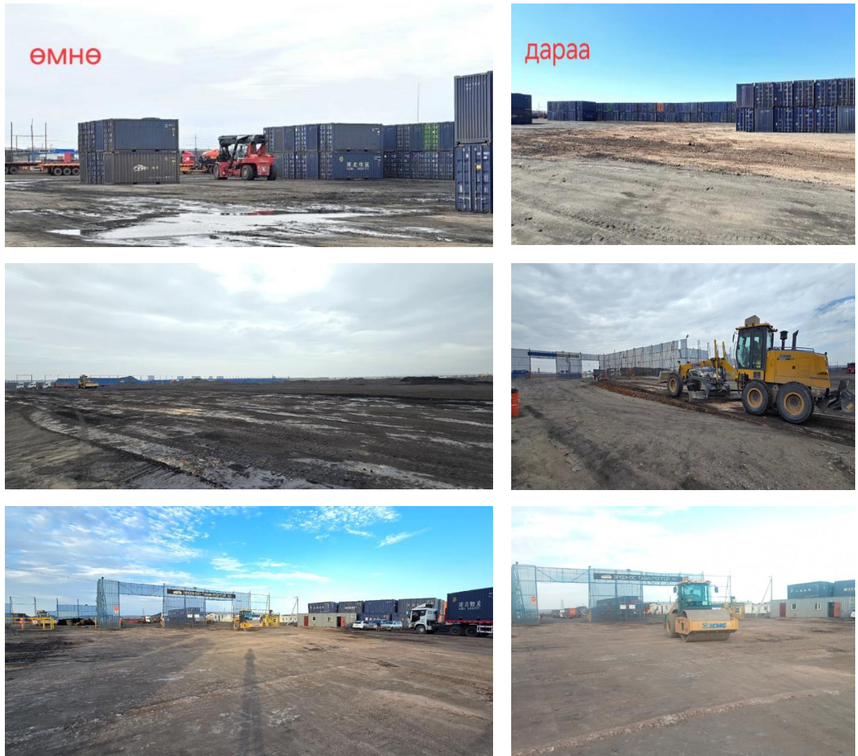
Зураг 12. Талбайд дэвсэлт хийж, нягтаршуулж буй байдал
