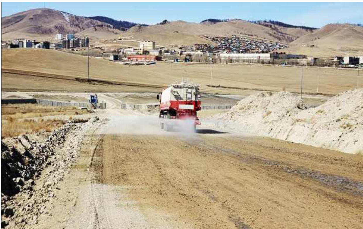
Зураг 13. Технологийн замын тоосжилт дарах усалгаа
