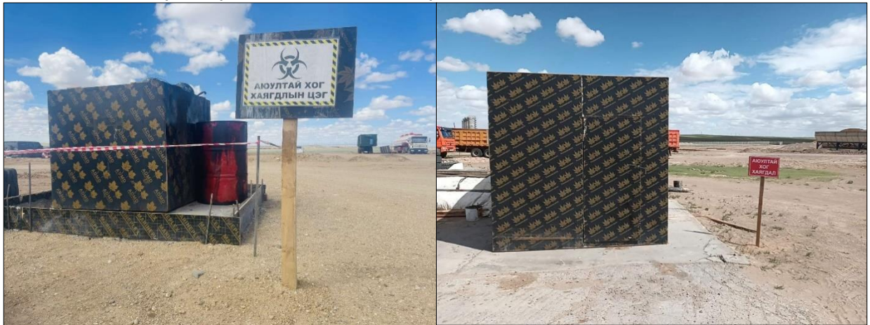
Зураг № 38. Аюултай хог хаягдлыг түр хадгалах цэг байгуулсан байдал
