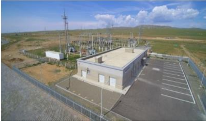
Зураг 1-7. Цахилгааны үндсэн дэд өртөөний барилга
