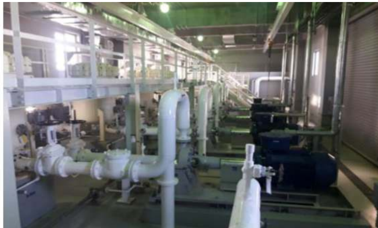
Зураг 1-13. Шатахууны агуулахын насосны станц
