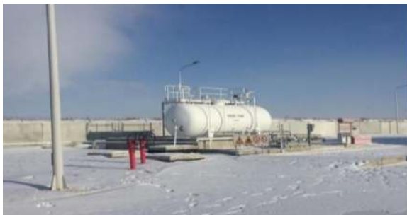
Зураг 1-10. Шатахууны агуулахын байгууламж, агуулахын хэрэглээний дизель түлш хадгалах 20 м 3 -ийн хэвтээ цилиндр ган сав
