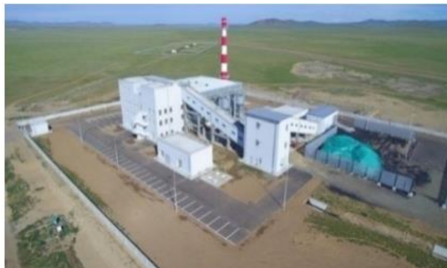
Зураг 1-6. Дулааны цахилгаан станц
