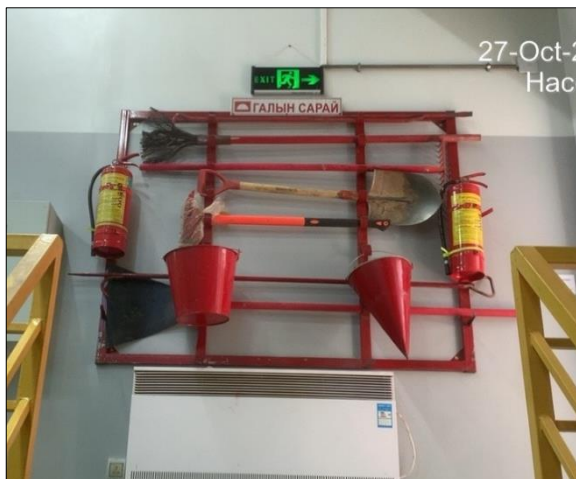
Зураг № 21. Өргөх насос станц 2, гүний ГХ-7 дугаар худагт байрлуулсан галын иж бүрдлийг суурилуулсан байдал
