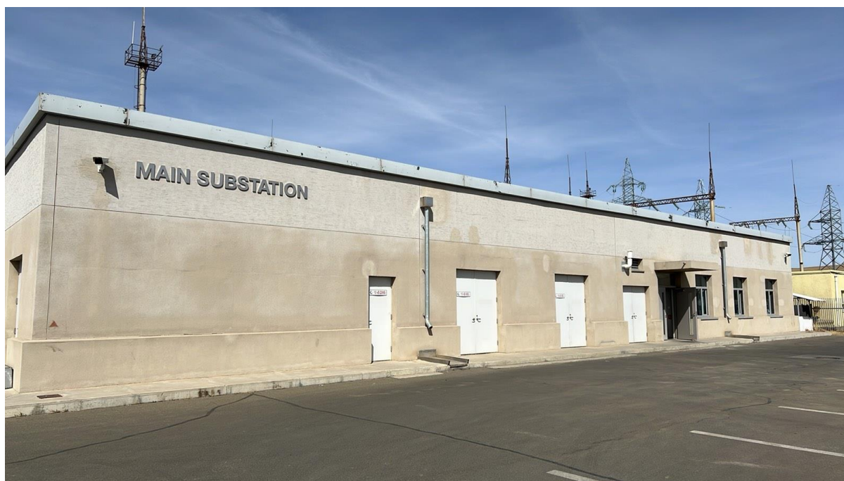
Зураг 1-3. Цахилгааны барилга
