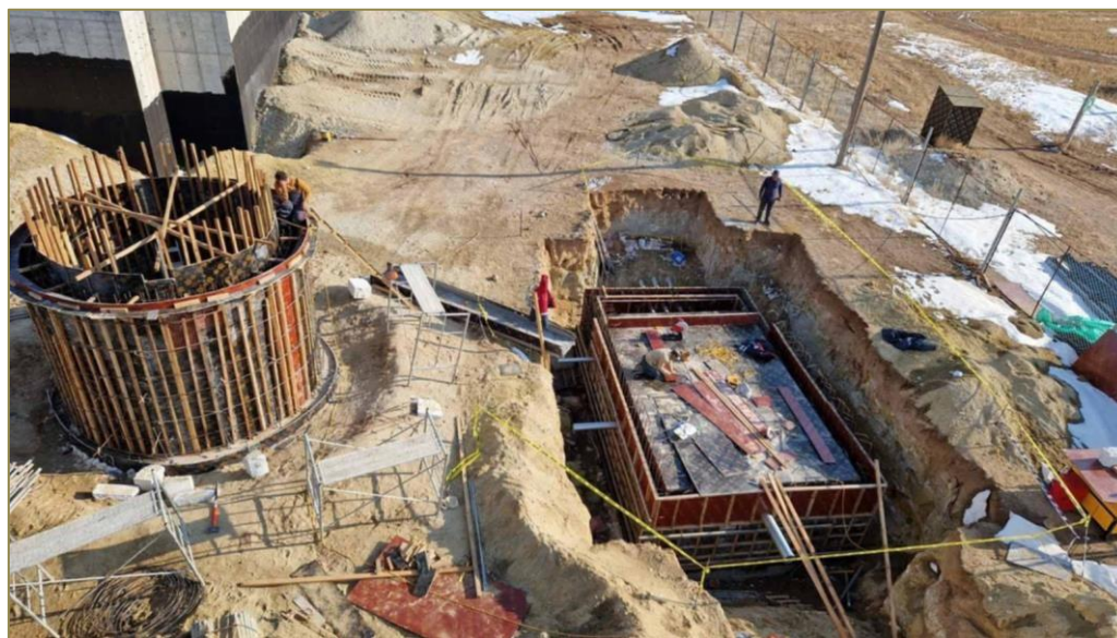
Илүүдэл лагийн сангийн барилга болон дотоод насос станцын барилгын хэв хашмал, арматурын ажил хийсэн байдал
