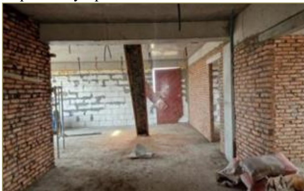
Захиргаа үйлдвэрлэлийн барилгын 2-р давхарын ханын өрлөгийн ажил хийсэн байдал
