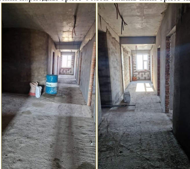
ЗҮ-барилгын 2-р давхарын дотор өрлөг, шавардлагын ажил хийсэн байдал
