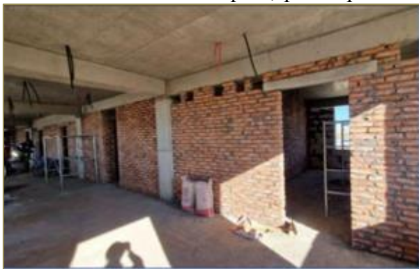
Захиргаа үйлдвэрлэлийн барилгын 2-р давхарын ханын өрлөгийн ажил хийсэн байдал
