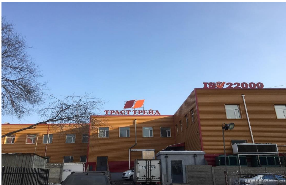
Зураг 3 Үйлдвэрийн гадна байдал
